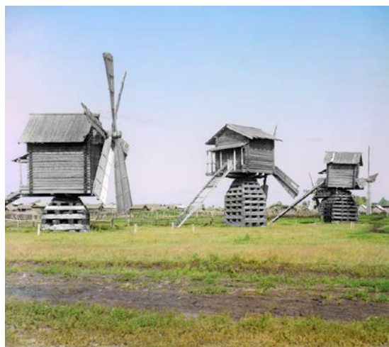
Wenn der Wind des Wandels weht, bauen die einen Schutzmauern und die anderen Windmühlen (Chin. Sprichwort) Bild 3 © S. M. Prokudin-Gorski (Public domain)
