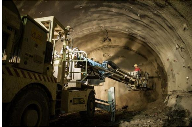
Abbildung 2: Bau des Koralmtunnels (Quelle: ÖBB INFRASTRUKTUR 2012)
