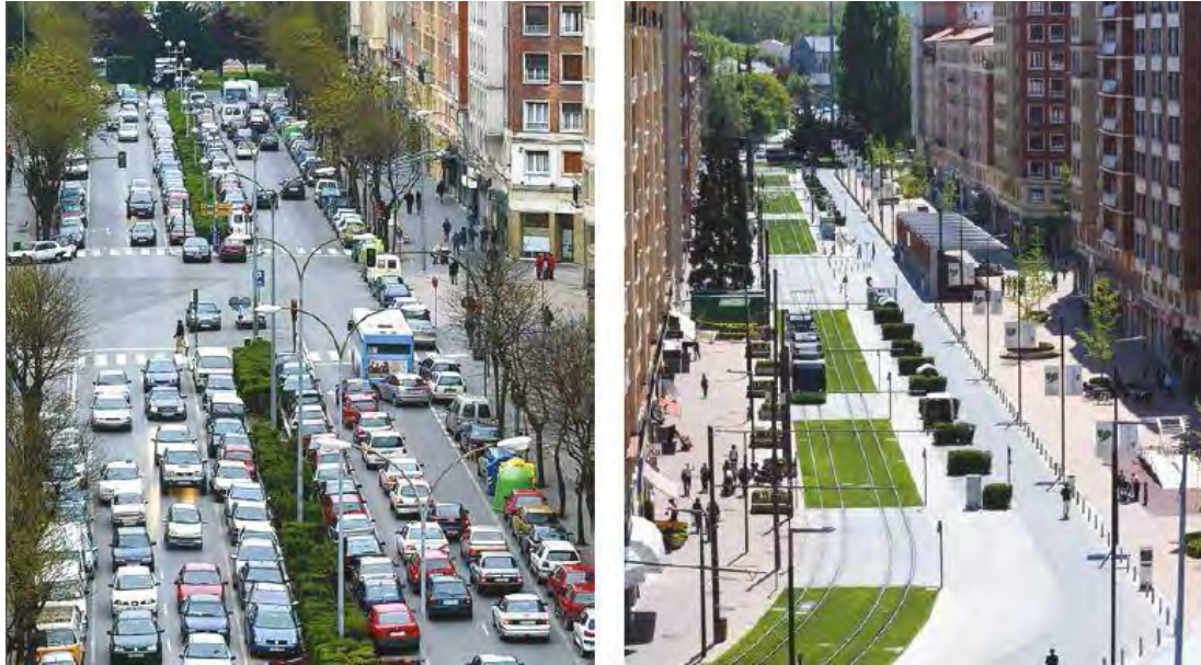
Abbildung 25: Die Straße Sancho el Sabio vor und nach dem Umbau
